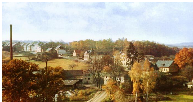
Blick ins alte Alaunwerk aus nordöstlicher Richtung
