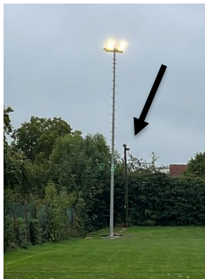
Der Neue 14m, dahinter der alte Mast
